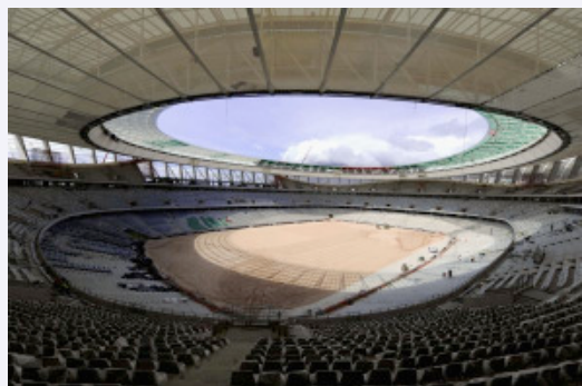
aktuelle Innenansicht des Greenpoint Stadium in Kapstadt
